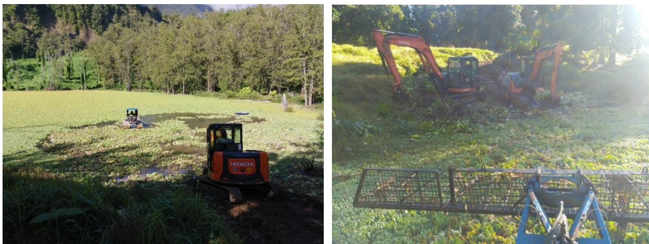
Figure 4 : Intervention curative sur la mare à poule d'eau
