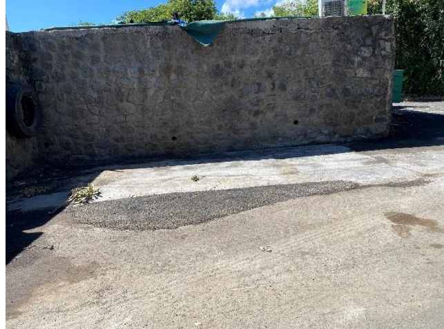
Figure 4 : Réfection plateforme basse et le bitume à l'avant de la déchèterie Sainte-Anne
