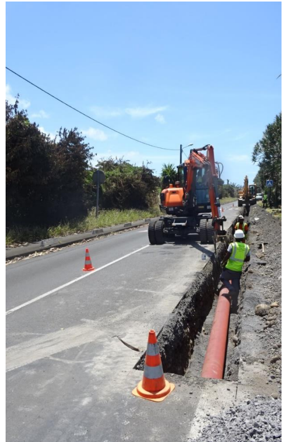
Figure 3 : Renouvellement de 750 ml de réseau d'assainissement sur la RD47 (Saint André)
