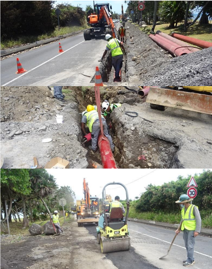
Figure 3 : Renouvellement de 750 ml de réseau d'assainissement sur la RD47 (Saint André)
