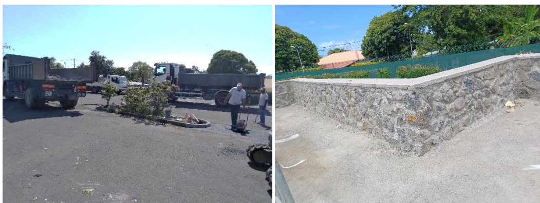
Figure 3 : Réduction terre-plein central et rehausse des quais gravats à Bras-Panon
