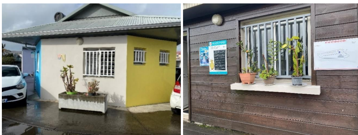
Figure 1 : Rénovation de peintures à Grand Canal et traitement du revêtement bois à Centre-Ville
