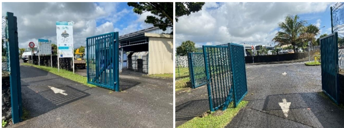
Figure 2 : Renouvellement des portails d'accès de Bras-Panon
